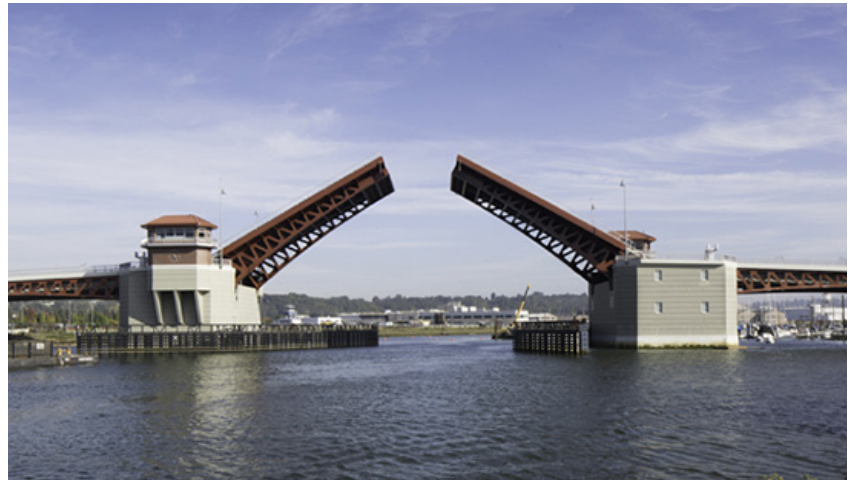
South Park Bridge en posición "elevada" (King County Road Services [Servicios de Carreteras del Condado de King])
