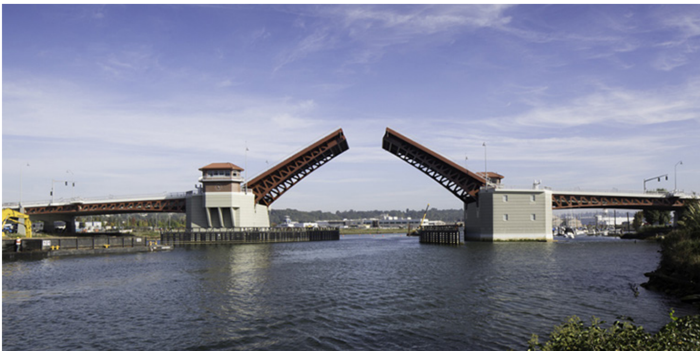
El South Park Bridge elevado para el paso de embarcaciones. Foto de los Servicios Viales (Road Services) de King County.
