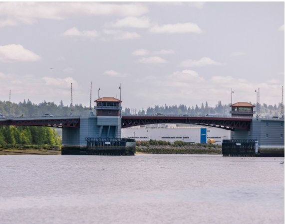
ក្រុមហ៊ុនស្ថាបនា ផ្ទៃកម្រិតកម្ម ទឹកសំណល់របស់ខោនធី KING (KING COUNTY WASTEWATER TREATMENT DIVISION)។
