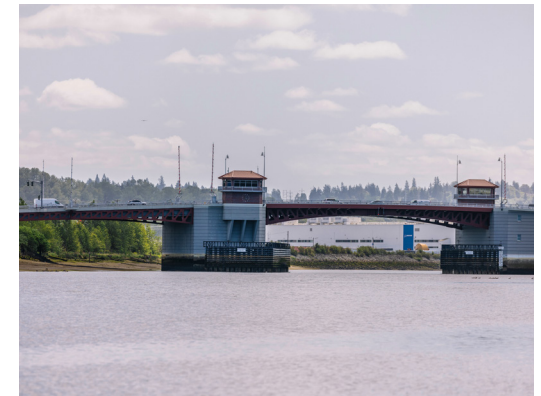
CRÉDITO DE LA FOTOGRAFÍA: KING COUNTY WASTEWATER TREATMENT DIVISION.
