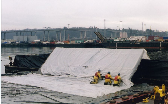
Use of spill apron
