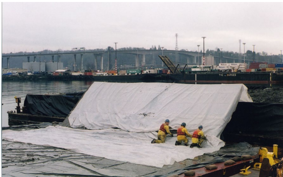
Use of spill apron
