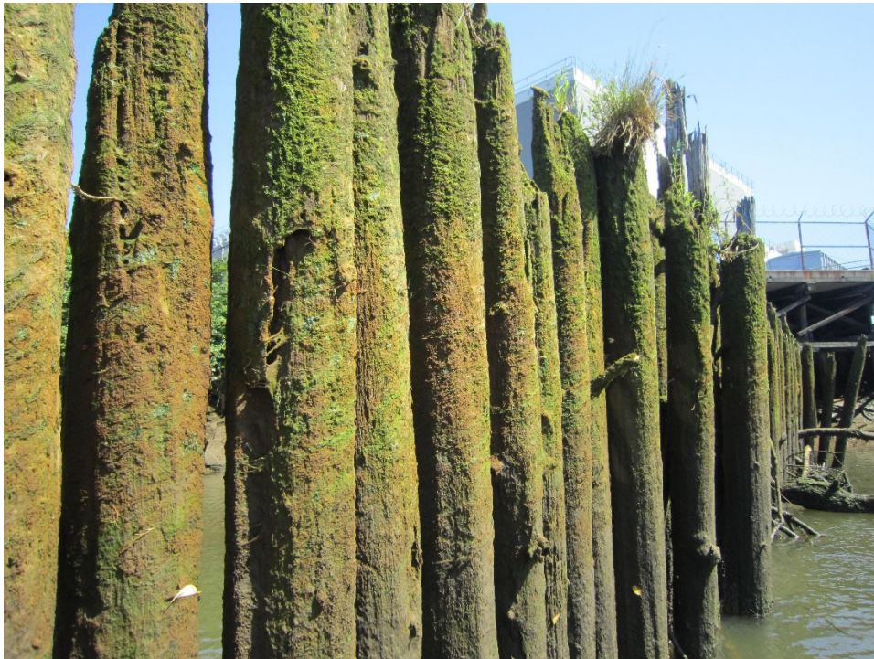
Photo ST07-08: Groin Piles
