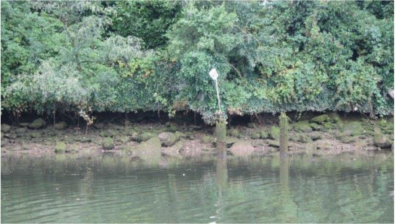
Photo ST18-01: Piles
